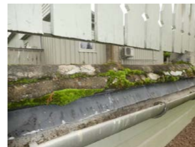
Mose på terrasse/tak over del med basseng
