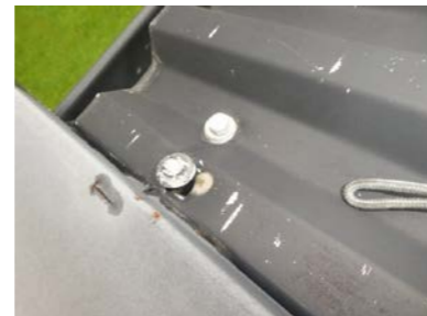
Utettheter rundt innfesting i taktekingen.
