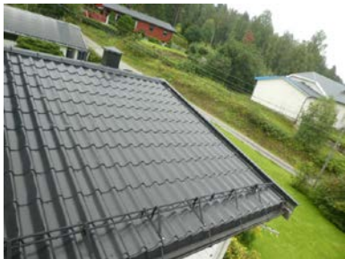
Bulker i taktekking
