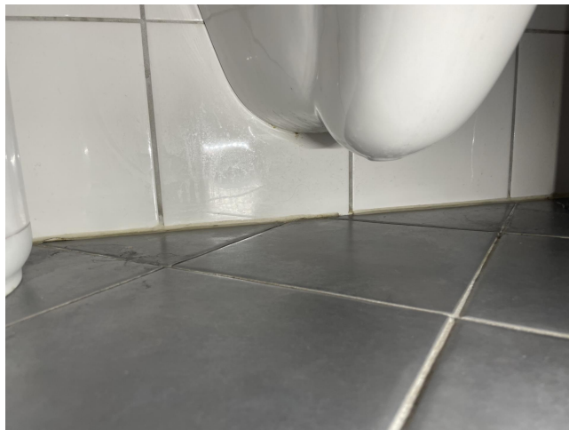
Ingen spalte, inspeksjonsmulighet eller dokumentasjon ved innebygget sisterner.
