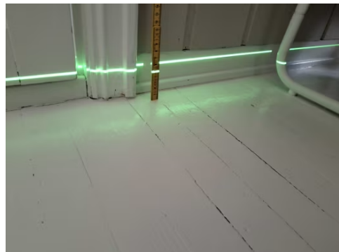
Etasjeskiller er kontrollert med nivelleringslaser.
