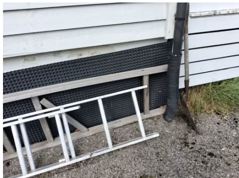
Synlig grunnmursplast på østsiden av boligen.
