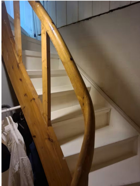
Trapp mellom kjelleretasje og 1. Etasje.
