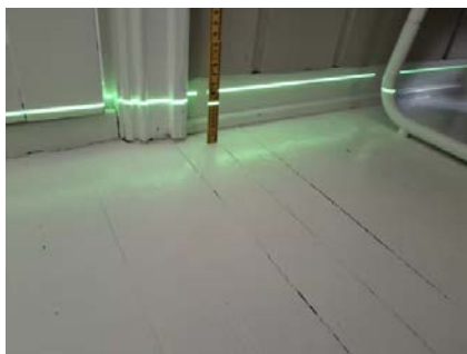
Etasjeskiller er kontrollert med nivelleringslaser.
