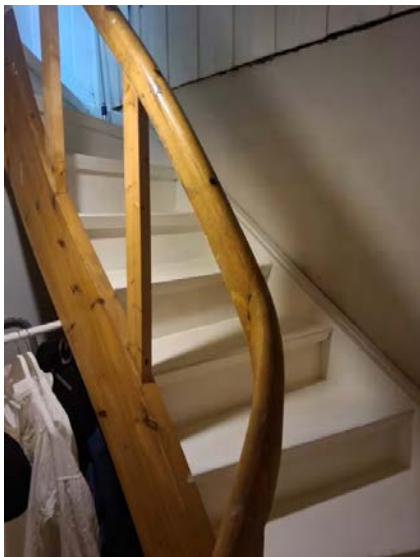
Trapp mellom kjelleretasje og 1. Etasje.
