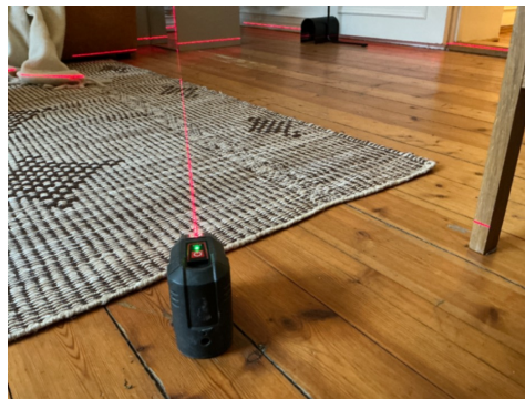
Nivellering i stue, avvik på ca. 10-20 mm
