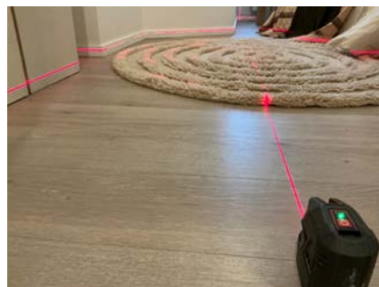
Nivellering soverom, avvik
