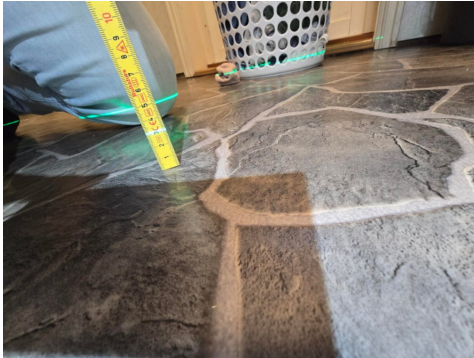
Bildet viser at jeg har brukt laser for å finne ut om fall forholdene på gulv. Ingen avvik
