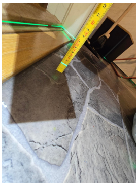
Bildet viser at jeg har brukt laser for å finne ut om fall forholdene på gulv. Ingen avvik
