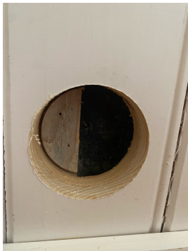
Fuktmåling i utforet vegg under terreng
