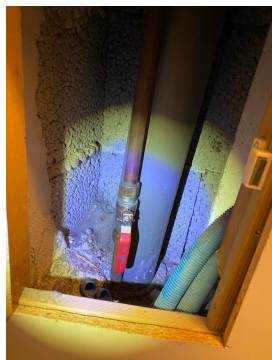
Varerør uten tetting i kjøkkenbenk Stoppekran
