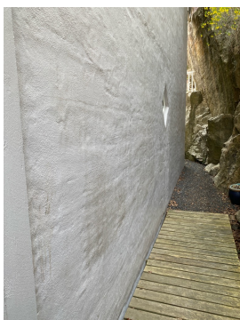
Liten sprekk i murpuss i gangen
