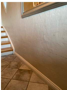
Liten sprekk i murpuss i gangen
