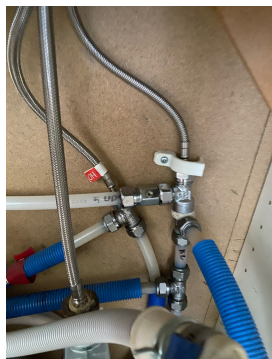
Varerør uten tetting i kjøkkenbenk Stoppekran
