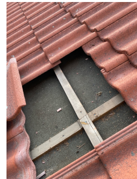
Asfaltpapp, impregnerte sløyfer og lekter
