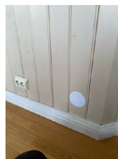
Fuktmåling uten utslag på måler, det vil si under 6%
