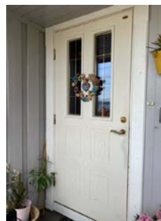
Inngangsdøren har noe slitasje på maling
