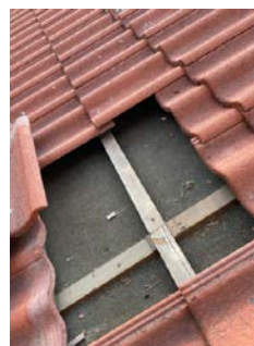
Asfalpapp, impregnerte sløyfer og lekter
