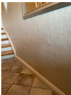
Liten sprekk i murpuss i gangen
