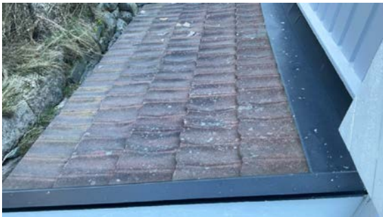
Takplater med bulker.
