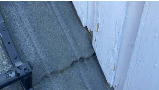
Kledning på sider på oppløft.
