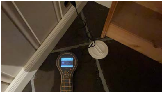
Fuktmåling i yttervegg under terreng.
