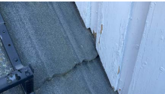
Kledning på sider på oppløft.
