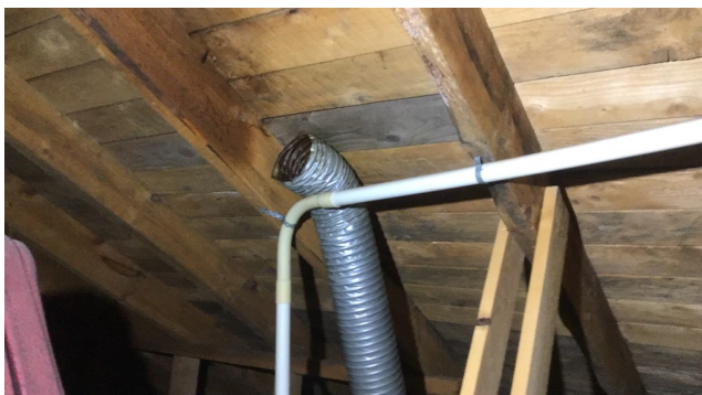
Luftekanal avsluttes under tak
