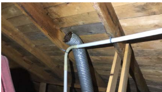
Lufttekanal avsluttes under tak
