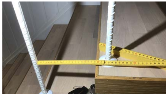
Åpningene i rekkverket er 22cm
