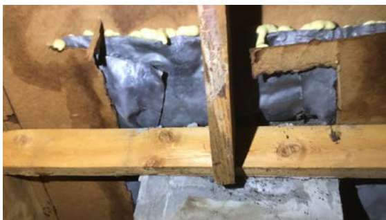
Utettheter i undertak
