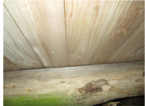
Bjelkelag av rundstokker.
