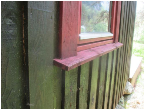
Deler av kledningen med tilhørende belistninger.
