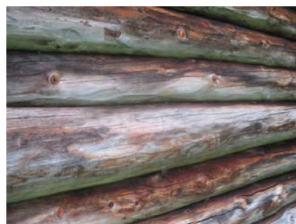
Eldre rundstokker som ikke er blitt kledd utvendig.
