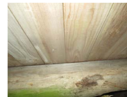
Bjelkelag av rundstokker.
