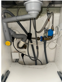
Rørapplegg i kjøkkenbenk med Waterguard
