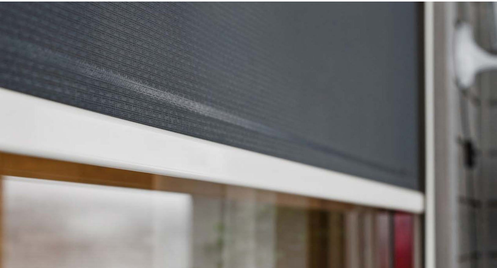
Det er solskjerming på stuevinduer
