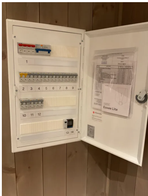
Sikringskap i gang.
