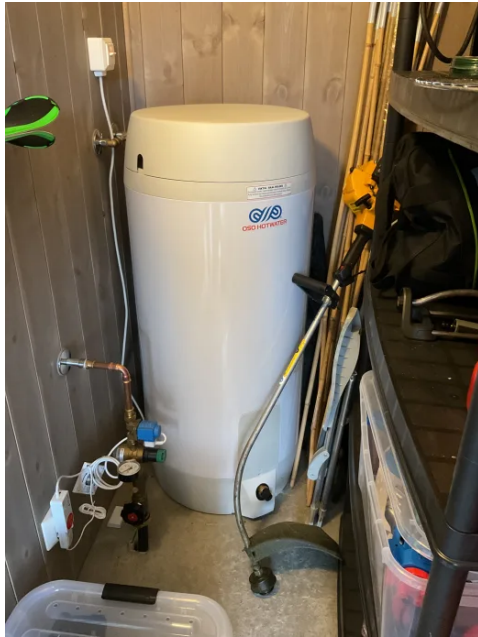
Varmtvannsbereder.
