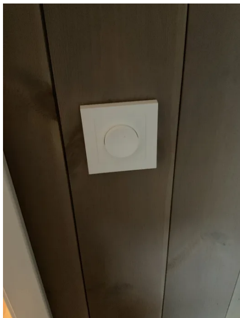
Deksel på dimmebryter er løst.
