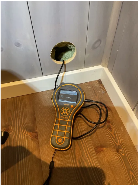
Hulltaking i tilstøtende rom.
