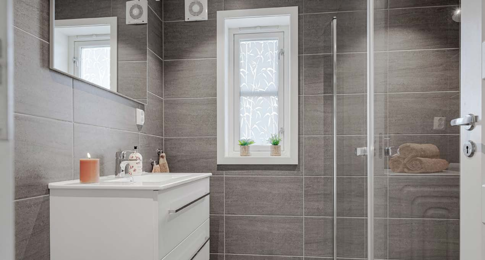
Flott og moderne baderom fra byggeåret 2021. Badet rommet har fliser på gulv og vegger, elektrisk gulvvarme, downlights i himlingen og mekanisk avtrekksvifte.
