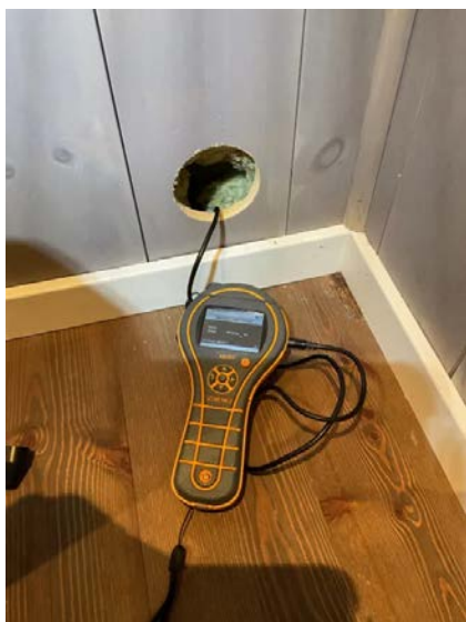
Hulltaking i tilstøtende rom.
