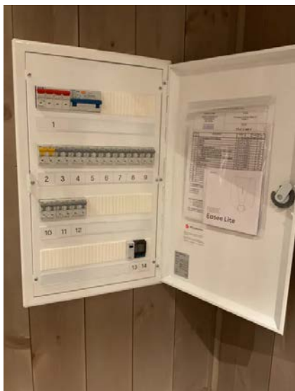
Sikringskap i gang.
