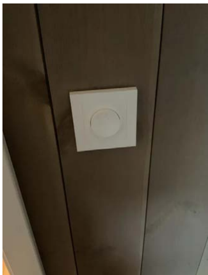
Deksel på dimmebryter er løst.
