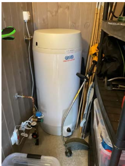
Varmtvannsbereder.
