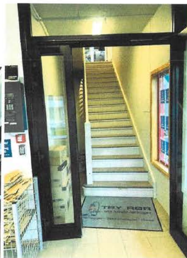
Trapp med rekkverk på 1 side.
