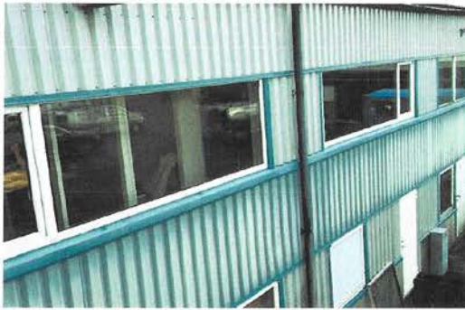
Falmet overfalte på stålplater.
