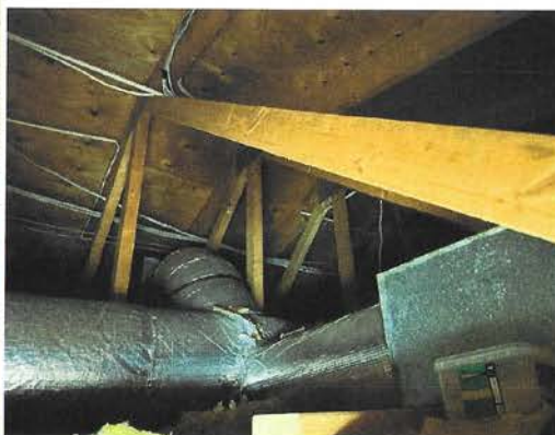
Undertak av kryssfiner og synlige ventilasjonskanaler.
