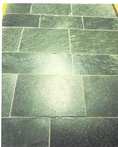
Eksempel på område med løse fliser.
