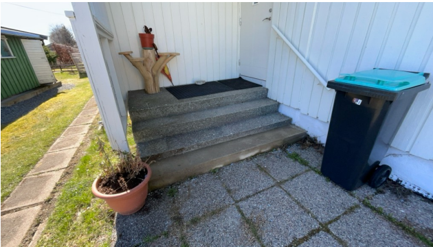
Besiktigelse av trapp.
