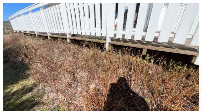
Kontroll av fundament.
