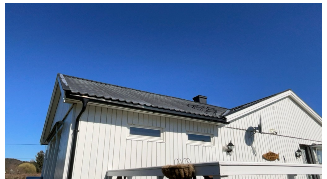
Besiktigelse av taktekke.
