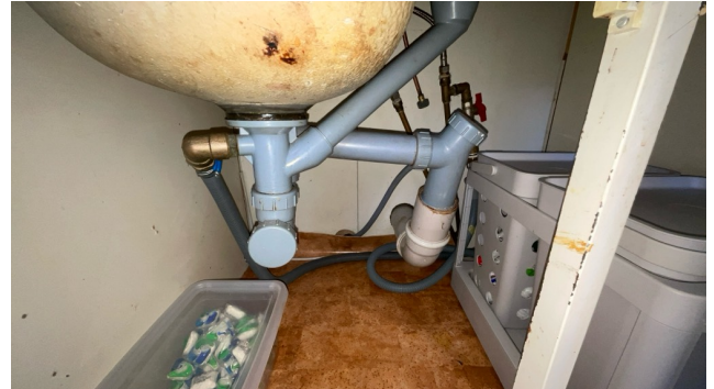
Besiktigelse av røropplegg.
