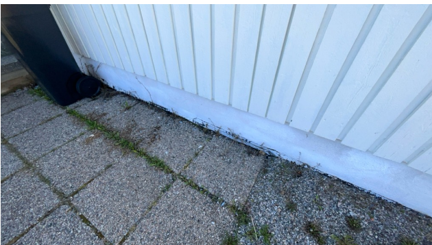
Kontroll av drenering/fuktsikring.
