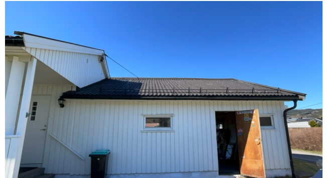
Besiktigelse av taktekke.
