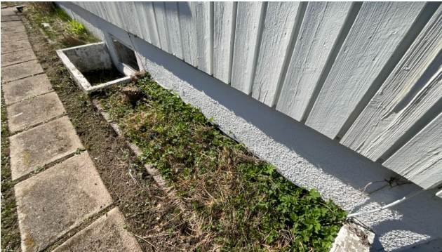
Kontroll av drenering/fuktsikring.
