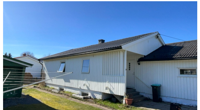
Besiktigelse av taktekke.
