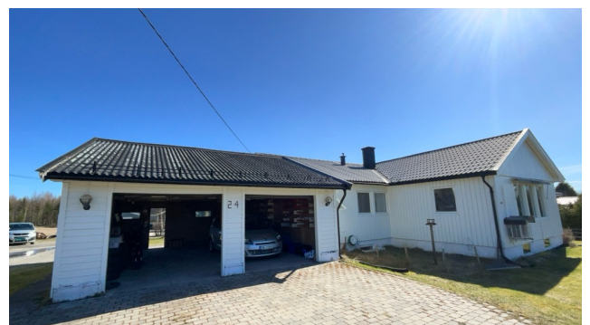
Besiktigelse av taktekke.
