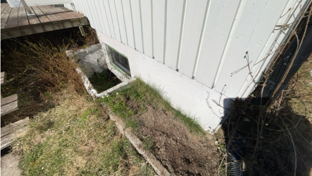
Kontroll av drenering/fuktsikring.
