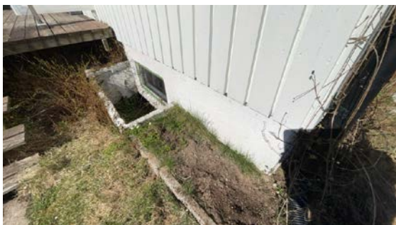
Kontroll av drenering/fuktsikring.
