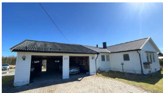
Besiktigelse av taktekke.
