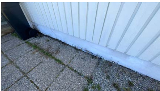
Kontroll av drenering/fuktsikring.
