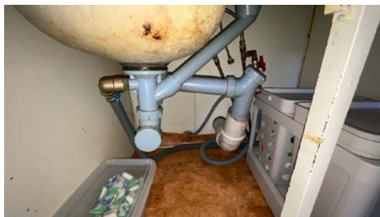
Besiktigelse av røropplegg.
