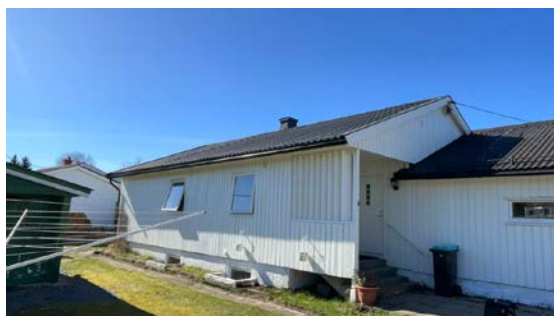
Besiktigelse av taktekke.
