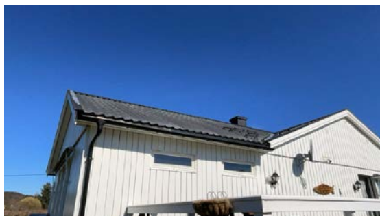
Besiktigelse av taktekke.
