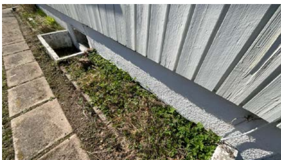
Kontroll av drenering/fuktsikring.
