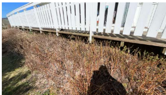
Kontroll av fundament.
