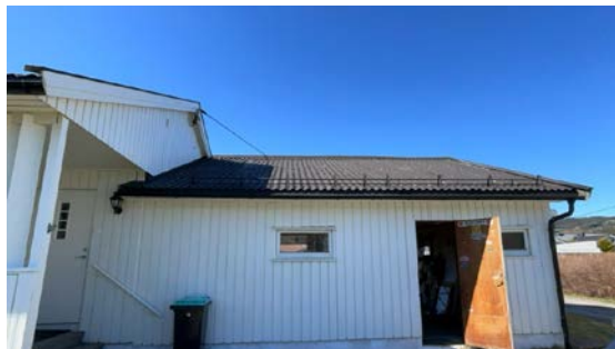
Besiktigelse av taktekke.
