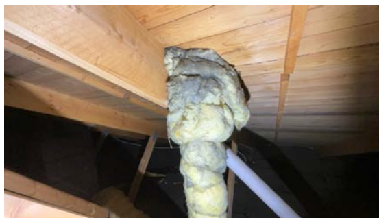
Kontroll rundt rørgjennomføringer.
