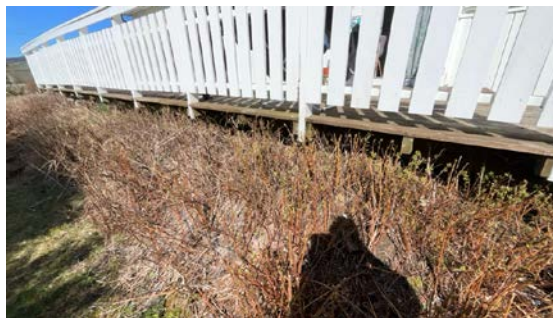
Kontroll av fundament.
