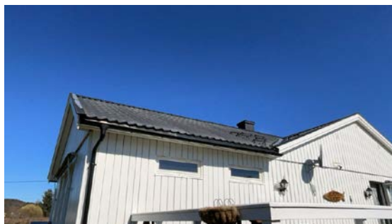
Besiktigelse av taktekke.
