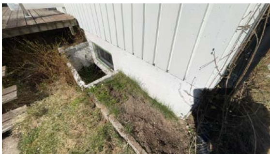
Kontroll av drenering/fuktsikring.
