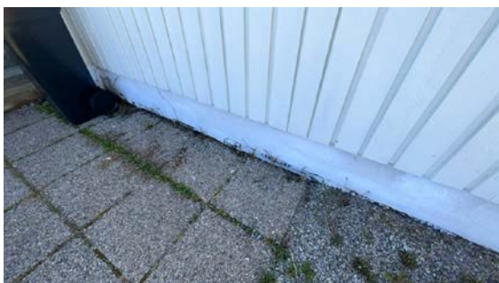
Kontroll av drenering/fuktsikring.
