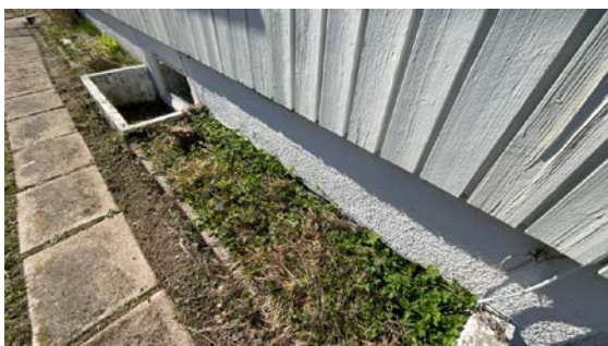
Kontroll av drenering/fuktsikring.
