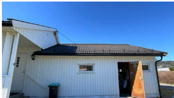
Besiktigelse av taktekke.
