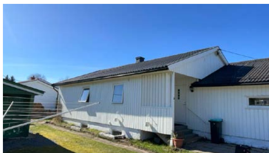
Besiktigelse av taktekke.
