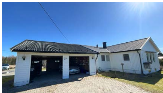
Besiktigelse av taktekke.
