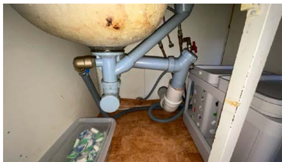
Besiktigelse av røropplegg.
