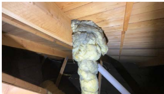
Kontroll rundt rørgjennomføringer.
