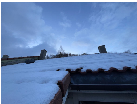
Taktekking var snødekket på befaringsdagen.
