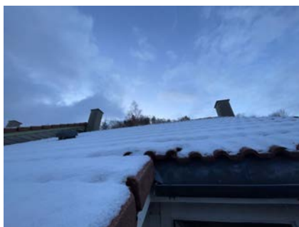
Taktekking var snødekket på befaringsdagen.
