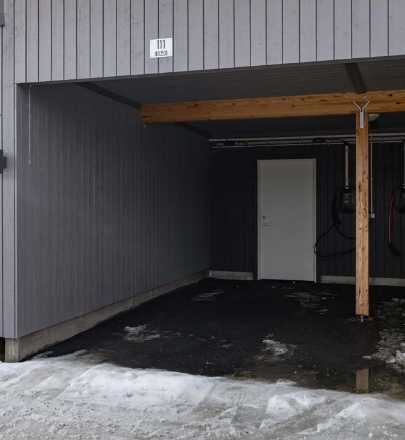
Biloppstillingsplass i felles carportanlegg følger leiligheten.
