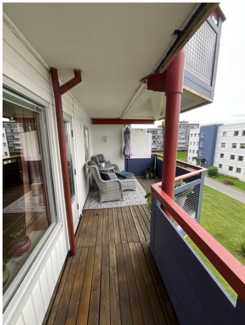
Viser balkong med adkomst fra stue.
