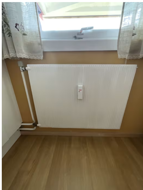
Viser radiator montert på kjøkken.
