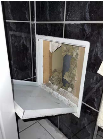
Viser inspeksjonsluke for avløpsrør. Det registreres ikke stakeluke.
