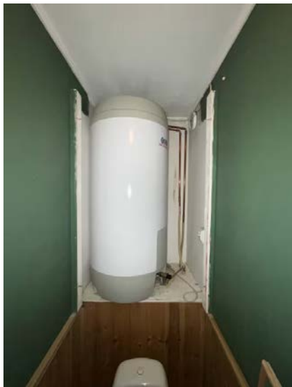
Viser bereder plassert i kasse på toalettrom.
