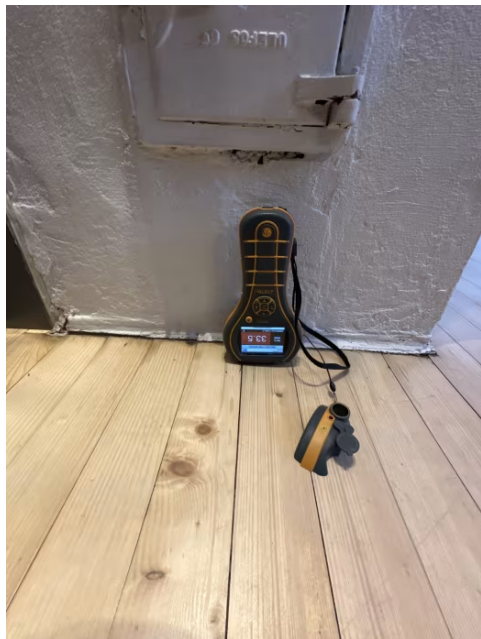
Det registreres fuktighet i tregulv rundt pipe.
