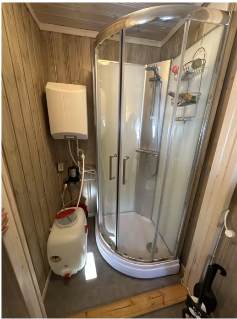
Viser dusjløsning med vanddunk, bereder og vannpumpe.
