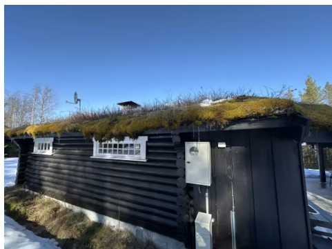
Det er ikke etablert takrenner.
