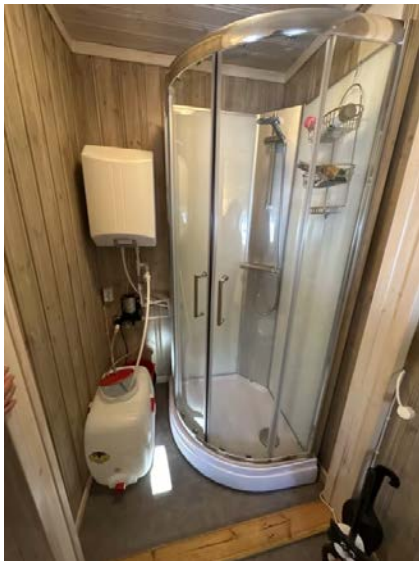
Viser dusjløsning med vandunk, bereder og vannpumpe.
