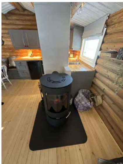
Viser ildsted montert i stue.
