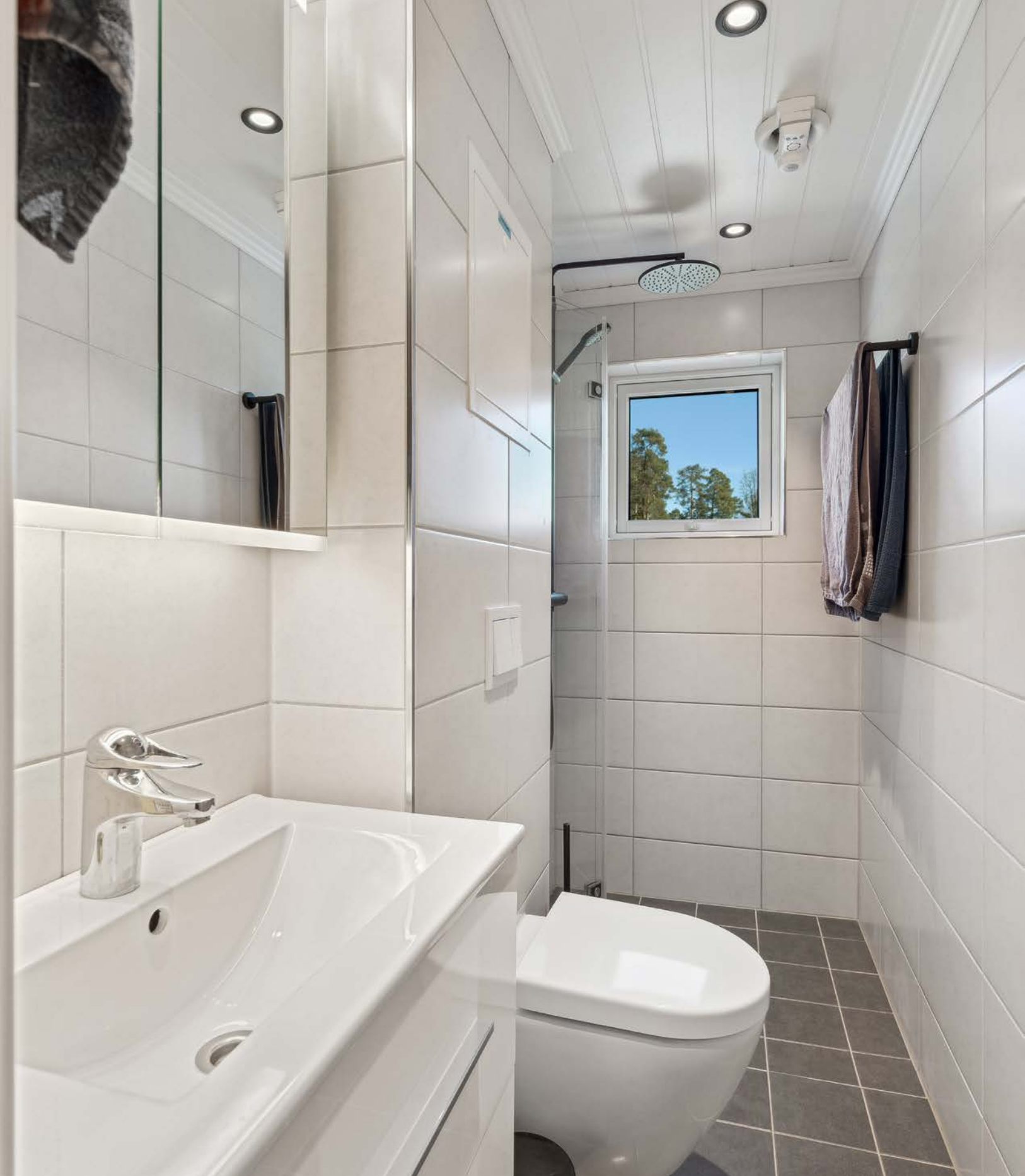
Pent flislagt bad med "regndusj"
