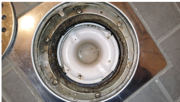
Kontroll av sluken.
