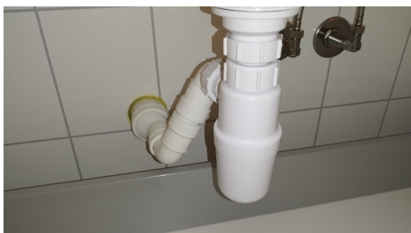
Kontroll av røropplegget.
