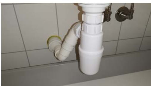
Kontroll av røropplegget.
