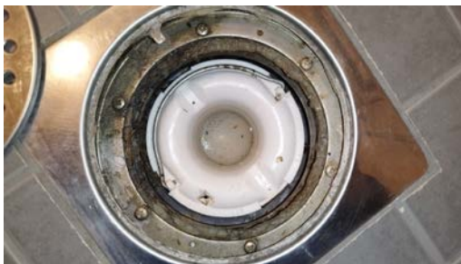
Kontroll av sluken.
