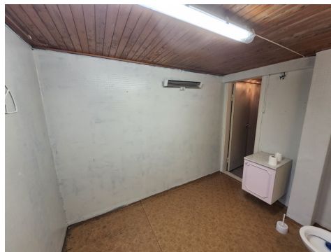
Vaskerom i kjeller
