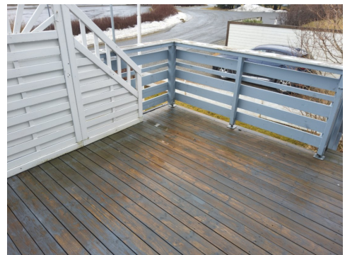
Terrasse over garasje
