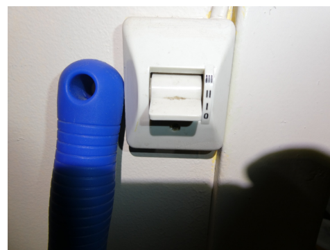
Elektrisk fasttilkobling til effektbryter.
