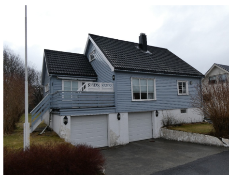
Støtte mur ved nedkjøring til garasje
