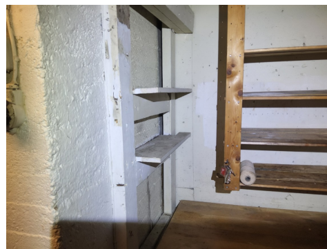
Kledd inn pipe sett fra garasje
