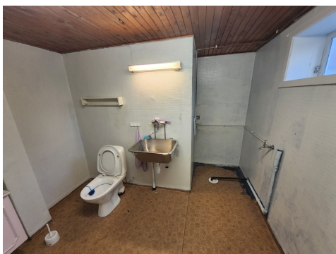
Vaskerom i kjeller
