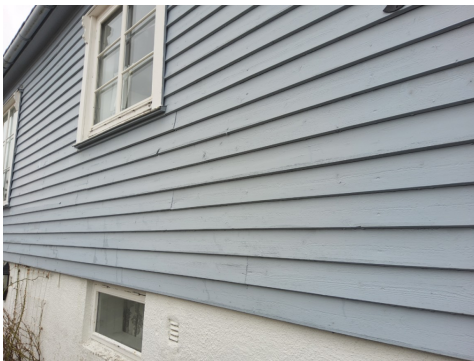
Kledning mot baksiden.
