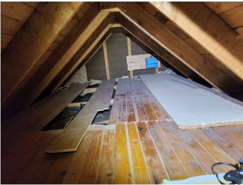
Fuktmåling i taktro uten unormale verdier.
