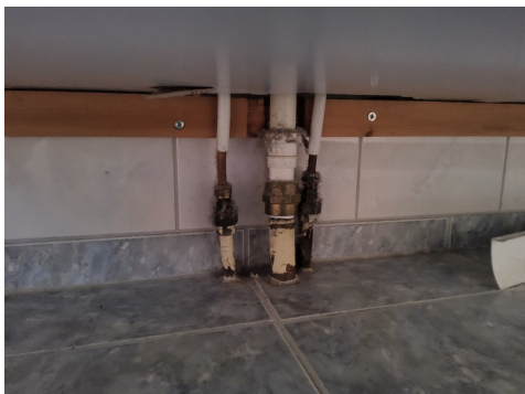
Rørgjennomføringer gjennom gulv ved servant
