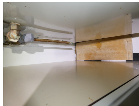
Overtrykksventil uten mulighet for avrenning til sluk.
