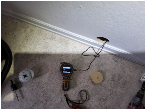
Fuktmåling mot bad.
