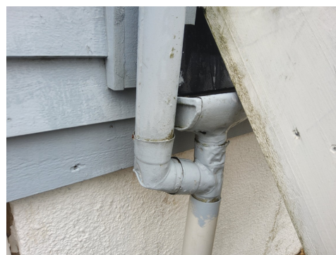
Sammenkobling av to nedløpsrør
