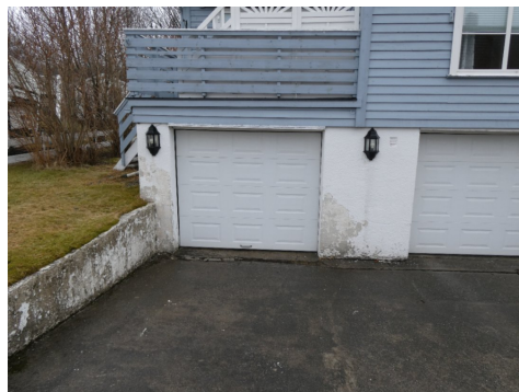
Støtte mur ved nedkjøring til garasje
