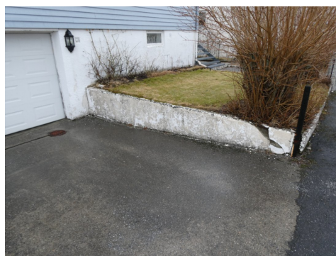
Støtte mur ved nedkjøring til garasje
