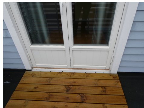
Balkondør på loftet er fra 2016 og i bra stand
