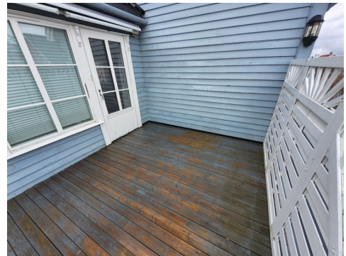
Terrasse over garasje
