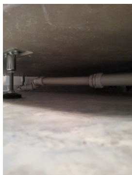
Rørgjennomføringer under dusj
