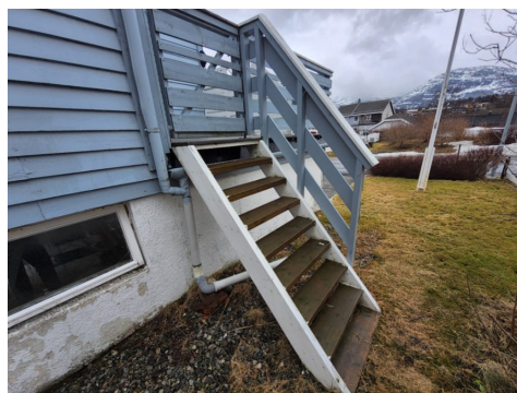
Bratt trapp opp til takterrasse over garasje
