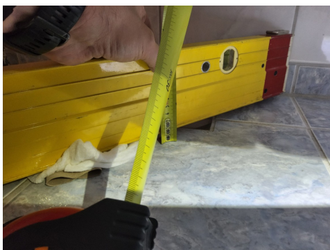
Fall fra dør mot sluk
