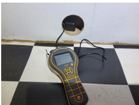
Fuktmåling mot vaskerom
