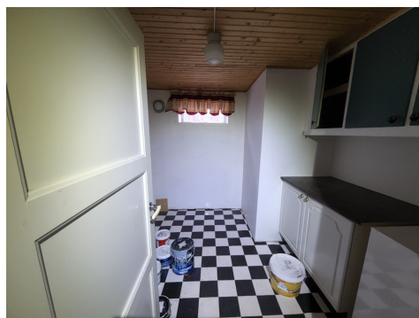
Gulv i kjellerbod
