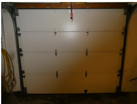
Garasjeport fra innsiden.
