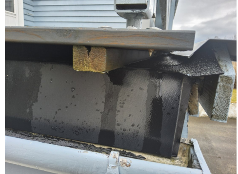
Terrasse over garasje
