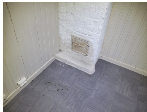
Sotluke i kjeller
