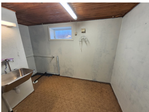
Vaskerom i kjeller
