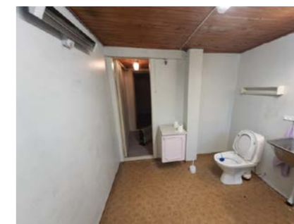
Vaskerom i kjeller
