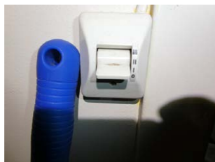
Elektrisk fasttilkobling til effektbryter.
