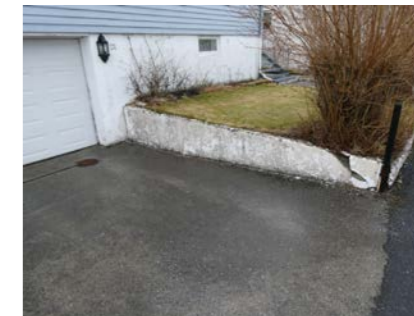
Støtte mur ved nedkjøring til garasje
