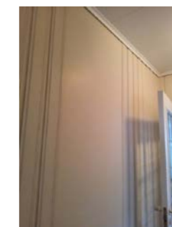
Ukjent plate på pipe i gang 1 etg.
