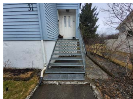
Trapp til inngangsparti av galvanisert stål. Strekkmetall i trinn.
