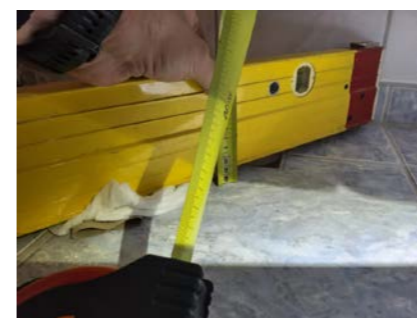
Fall fra dør mot sluk
