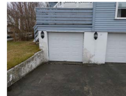
Støtte mur ved nedkjøring til garasje
