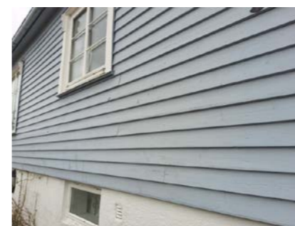
Kledning mot baksiden.
