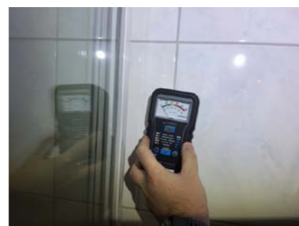
Ingen utslag på fukt.
