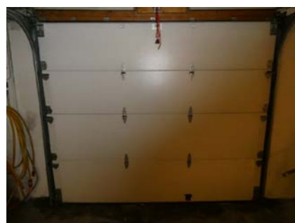
Garasjeport fra innsiden.
