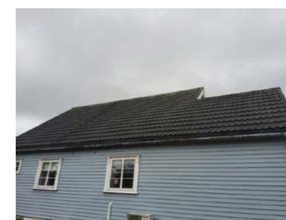
Bildet viser takteking av stål med ru overflate som er relativt mye begrodd med mose/lav. Bildet er tatt mot husets bakside.
