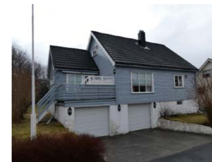
Støtte mur ved nedkjøring til garasje
