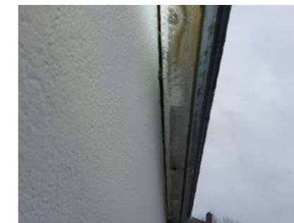
Lite/ingen lufting bak kledning.
