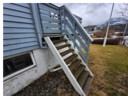
Bratt trapp opp til takterrasse over garasje
