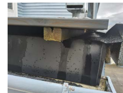
Terrasse over garasje
