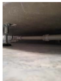
Rørgjennomføringer under dusj
