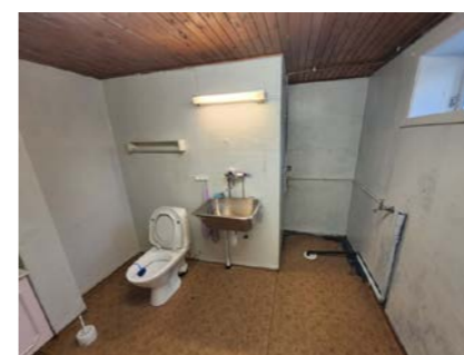
Vaskerom i kjeller
