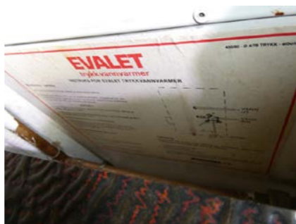
Eneste synlige merke på bereder
