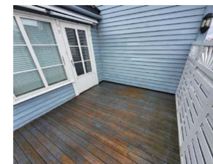
Terrasse over garasje
