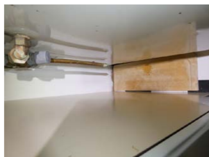
Overtrykksventil uten mulighet for avrenning til sluk.
