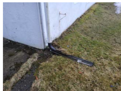
Bildet viser delvis bortledning av vann. Men det er flatt terreng og vannet finner lett veien tilbake mot grunnmur
