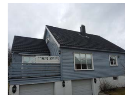
Bildet viser takteking av stål med ru overflate som er relativt mye begrodd med mose/lav. Bildet er tatt mot husets fremside.
