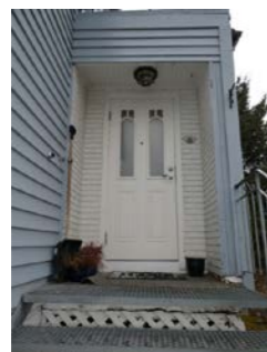
Hovedinngangsdører er av nyere dato og er i bra stand
