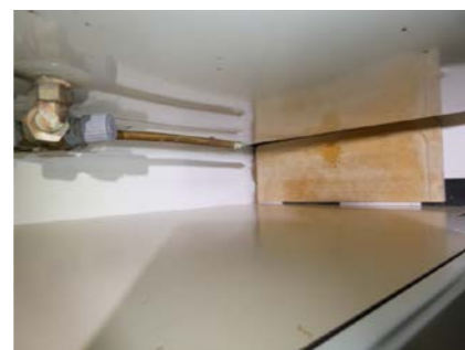
Overtrykksventil uten mulighet for avrenning til sluk.
