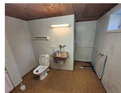
Vaskerom i kjeller
