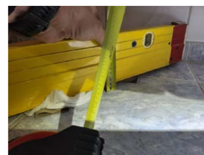
Fall fra dør mot sluk
