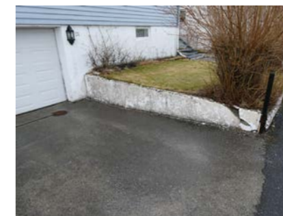
Støtte mur ved nedkjøring til garasje
