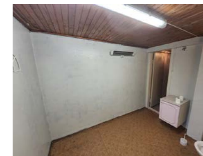
Vaskerom i kjeller
