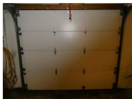
Garasjeport fra innsiden.
