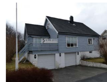
Støtte mur ved nedkjøring til garasje
