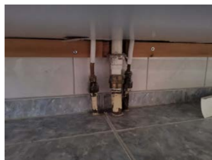
Rørgjennomføringer gjennom gulv ved servant
