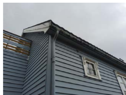
Bildet viser takrenne og nedløpsrør på baksiden av huset
