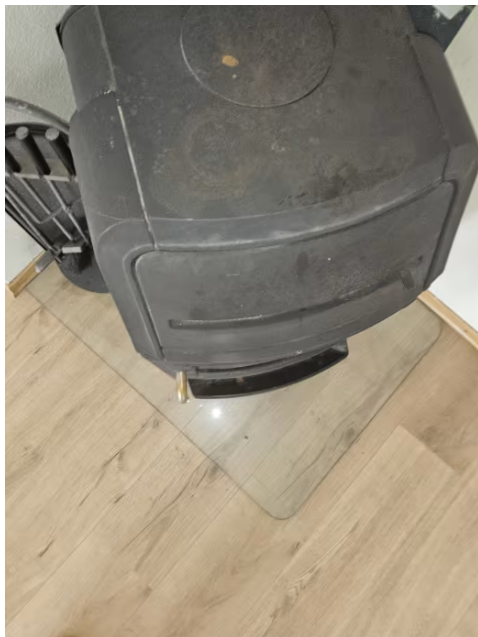
Ubrennbar plate oppfyller ikke minstekravet.
