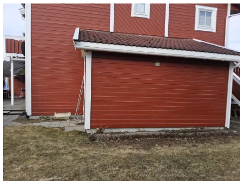
Boligen er kledd med liggende trekledning.
