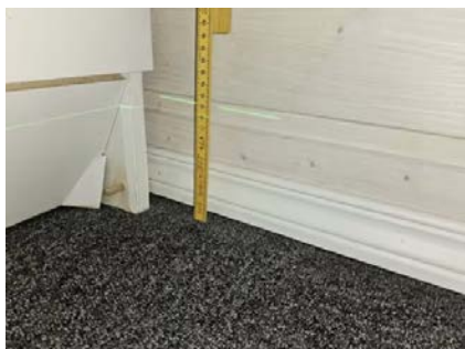
Kontrollmåling er utført med nivelleringslaser.
