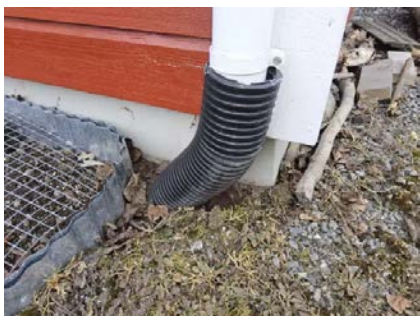
Takvann er ledet ned i drensrør.
