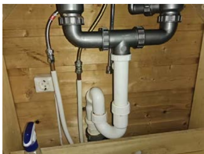
Leiligheten har synlige avløpsrør av plast.
