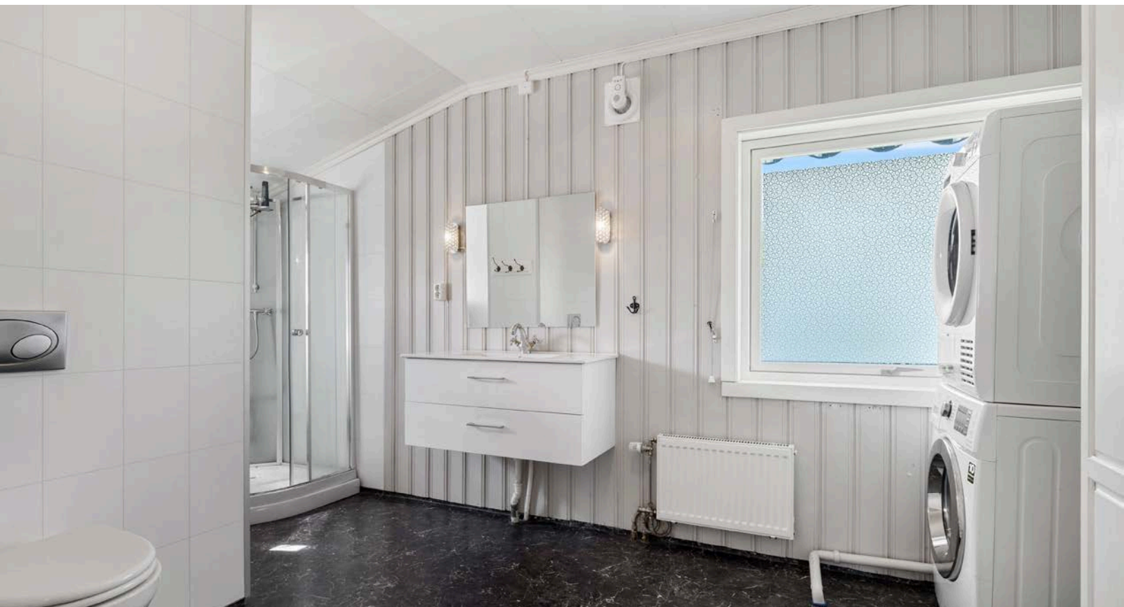
Baderommet i 2. etasje ble pusset opp i 2017 med ny membran og nytt våtromsbelegg på gulv. Det er montert ventilasjonsvifte på vegg.
