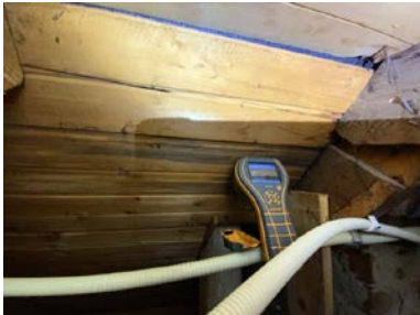
Ved enkel fuktmåling registrerte jeg tørre verdier.
