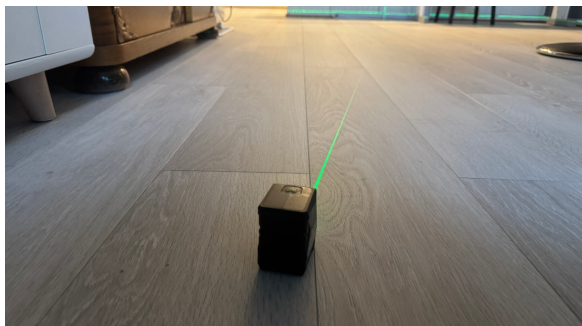
Kontroll av planavvik.
