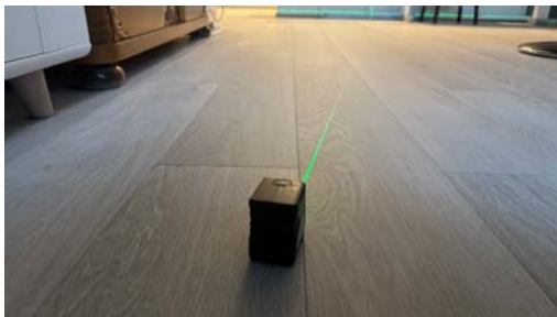
Kontroll av planavvik.
