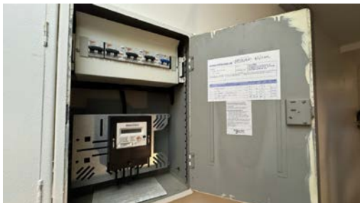
Kontroll av el-skap og kursfortegnelse.
