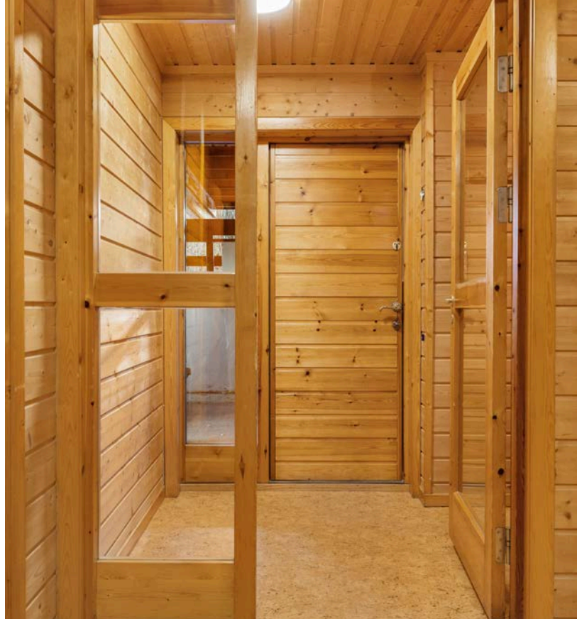
Entréen har vinylbelegg på gulv og liggende trepanel på veggene.
