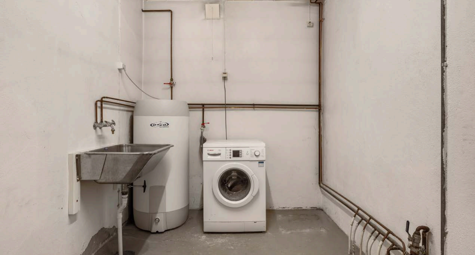
Eldre vaskerom i underetasjen med støpt gulv og overflater med malt murpuss. Rommet er utstyrt med skyllekar, varmtvannsbereder og opplegg for vaskemaskin.
