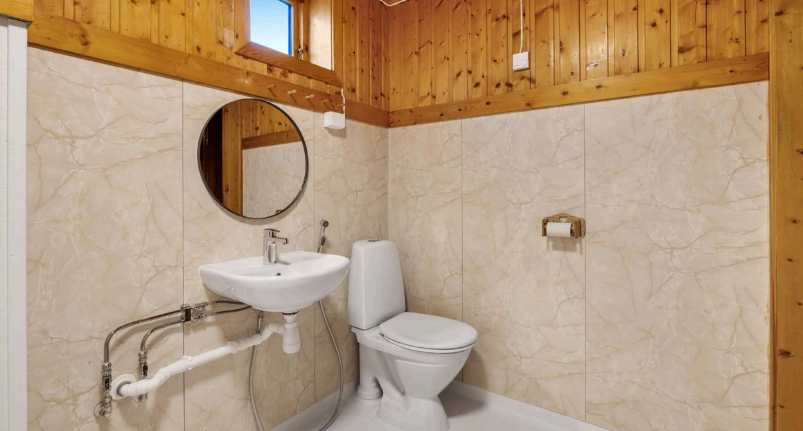
Eldre baderom i underetasjen fra byggeåret. Baderommet har varmekabler og våtromsbelegg på gulv malt med våtromsmaling i 2024.
