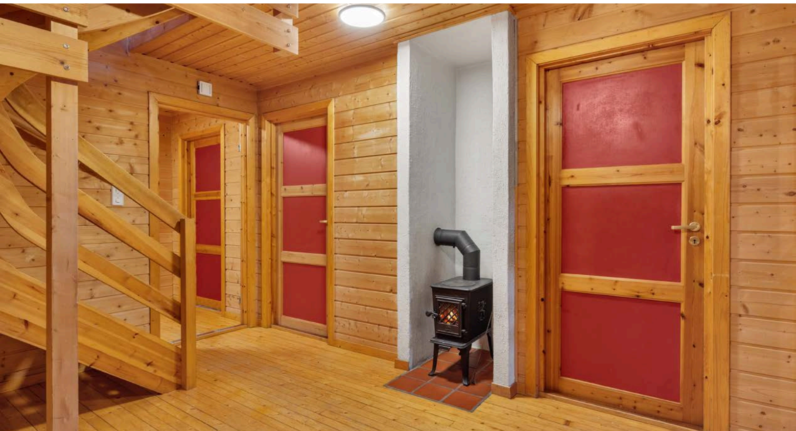
Peisovn montert i gang i underetasjen i 2023.
