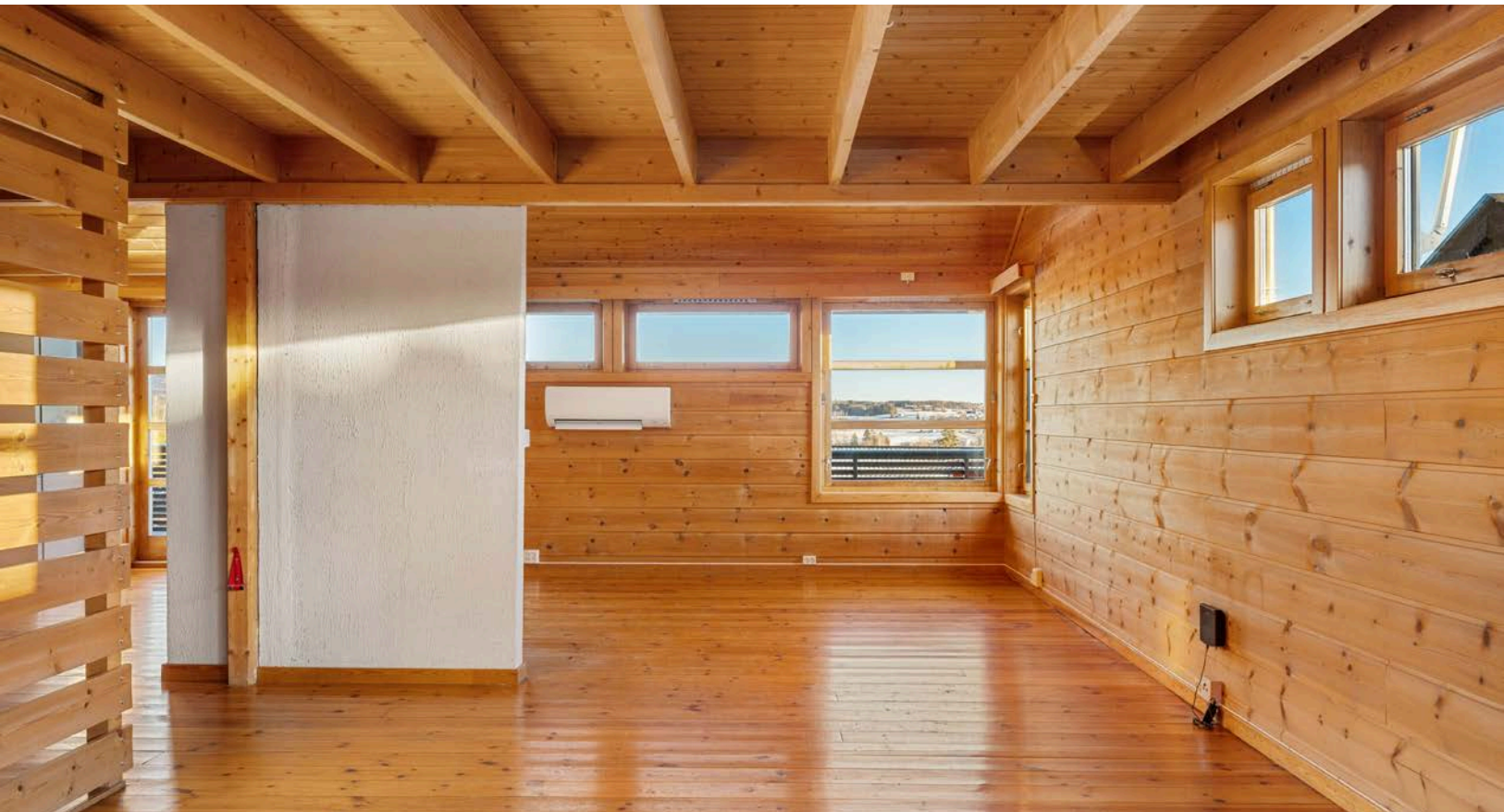
Montert luft-til-luft varmepumpe fra 2016 som sørger for en god og jevn varme på vinterstid.
