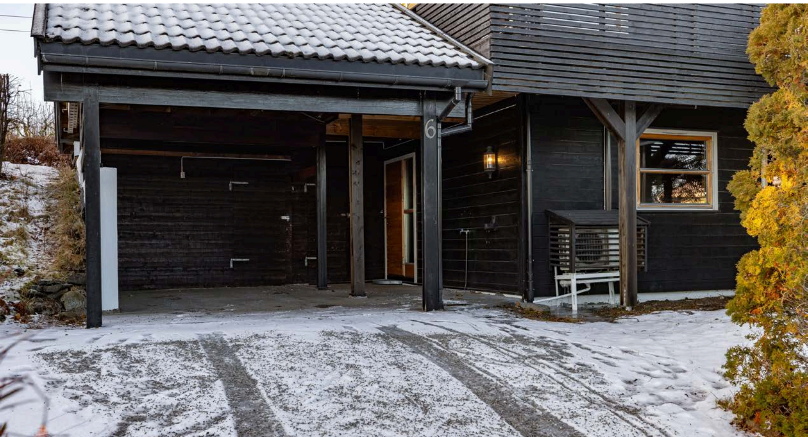
Inntilbygget carport på ca. 28m 2 med vedbod og bod, samt loft på ca. 17m 2 (ikke måleverdig areal).
