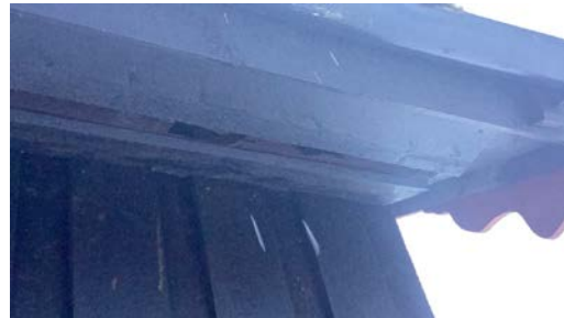
Stedvis skader på insektsnett
