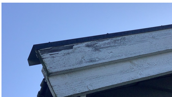
Eksempel på værslitt vindski.
