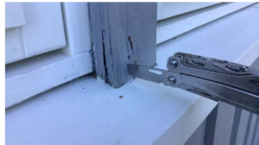
Omramming er ført helt ned til vannbrett, og dette har ført til råteskader.
