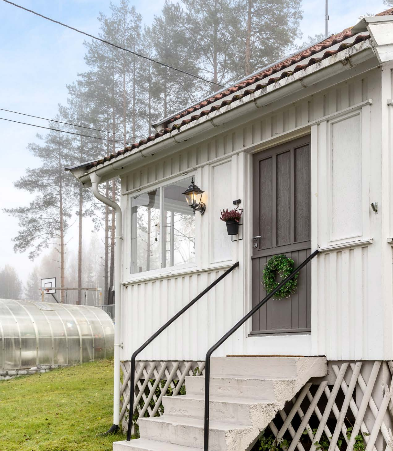
Adkomsten til boligen er gruslagt og har støpt trapp og klassisk utebelysning.
