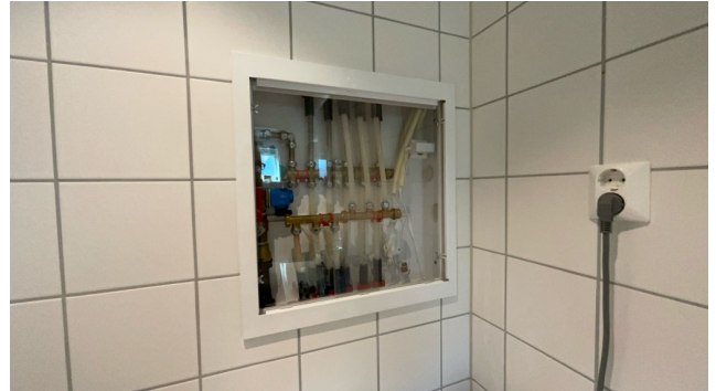
Besiktigelse av røropplegg.
