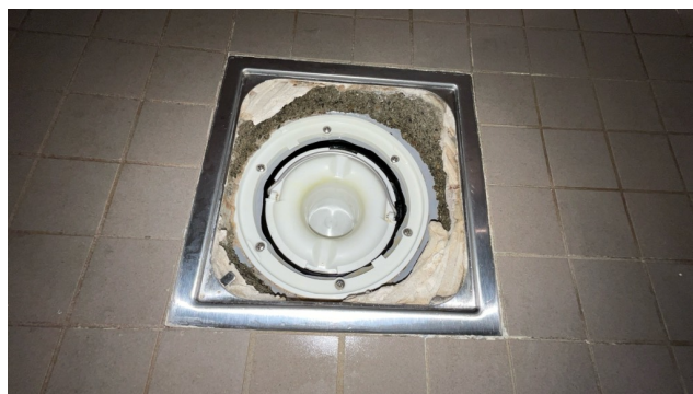
Kontroll av sluk.
