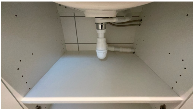
Besiktigelse av røropplegg.
