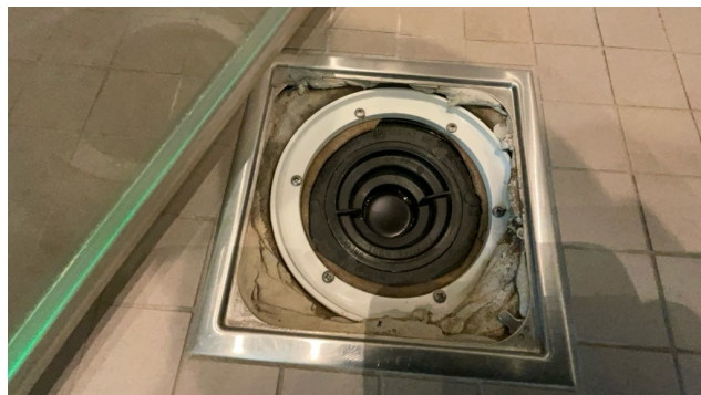
Kontroll av sluk.
