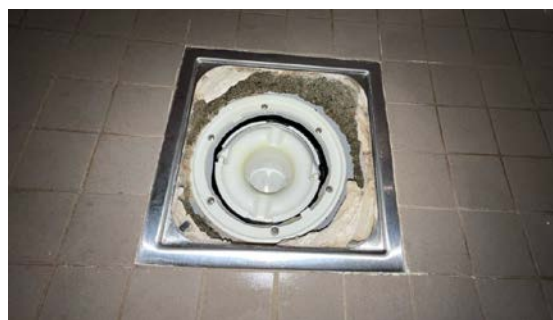
Kontroll av sluk.
