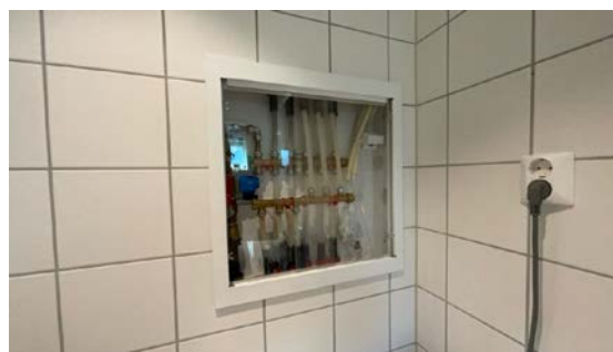
Besiktigelse av røropplegg.
