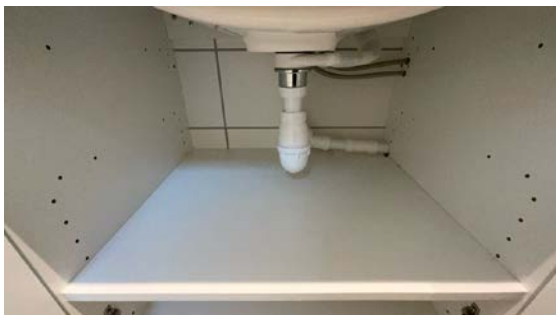
Besiktigelse av røropplegg.
