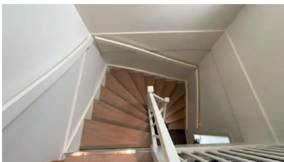
Besiktigelse av trapp.
