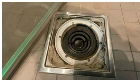
Kontroll av sluk.
